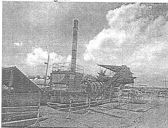
Fotografía No. 4 Planta Asfáltica Obras Especiales -OBRESCA C.A.
